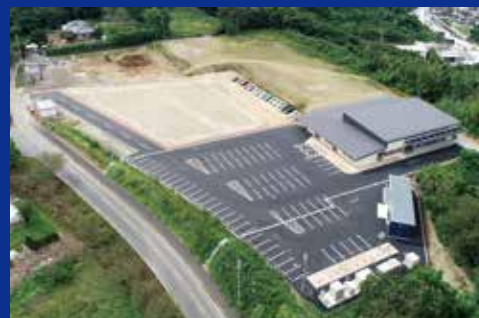
三角町 波多 | 三角防災拠点センター外構工事 熊本県宇城市 総務部 防災消防課
