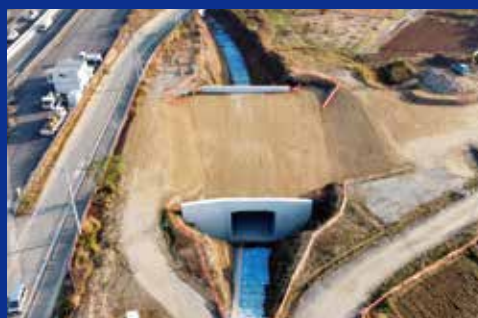
熊本市北区 下硯川町 | 熊本3号 下硯川地区改良3期工事 国土交通省九州地方整備局熊本河川国道事務所
