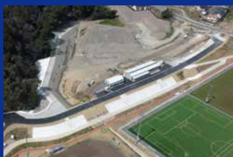
甲佐町 船津 | 緑川船津地区築堤工事 国土交通省九州地方整備局熊本河川国道事務所
