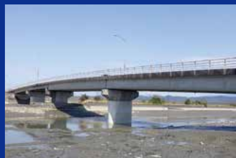
松橋町 砂川 | 八代不知火線(砂川大橋)防災安全交付金 (橋梁補修)P1工事 他合併 熊本県県央広域本部宇城地域振興局
