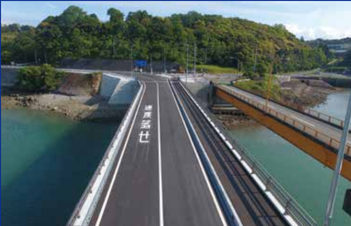
三角町戸馳 | 戸馳A1、A2道路改良 熊本県宇城市
