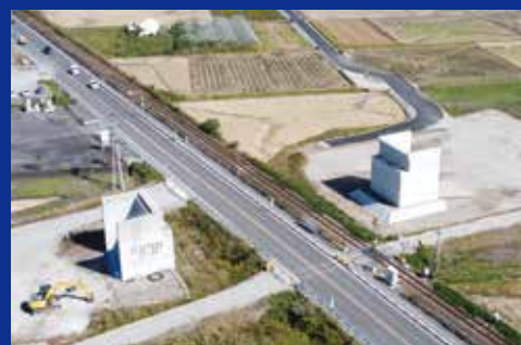
上綱田町 | 熊本57号 上綱田橋下部工(A2)外工事 国土交通省九州地方整備局八代河川国道事務所
