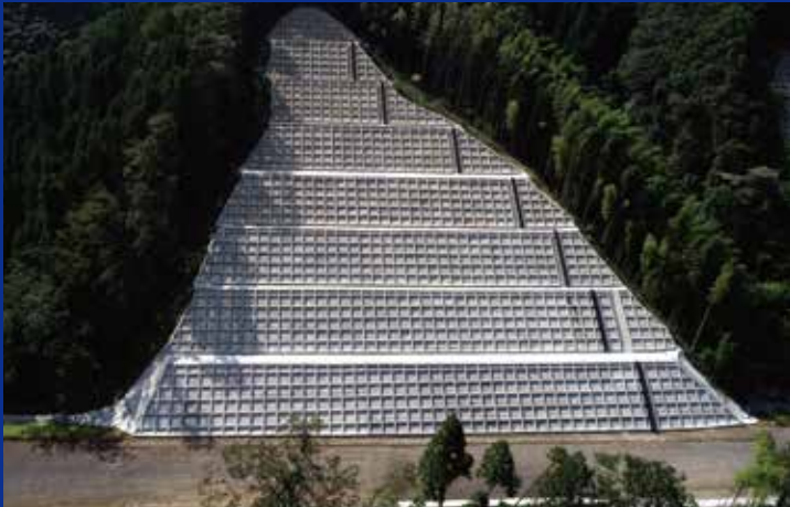
山都町北中島 | 九州中央道 城ノ尾地区改良工事 国土交通省九州地方整備局熊本河川国道事務所
