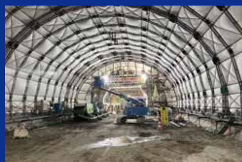
宇土市 | 熊本57号笹原トンネル新設工事 五洋建設株式会社
