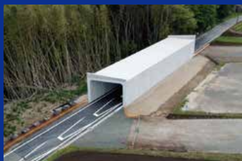
野々島 | 熊本57号 大津熊本道路20号函渠外工事 国土交通省九州地方整備局熊本河川国道事務所
