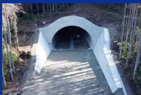
宇土市 | 熊本57号糖塚山トンネル新設工事 東急・時里JV
